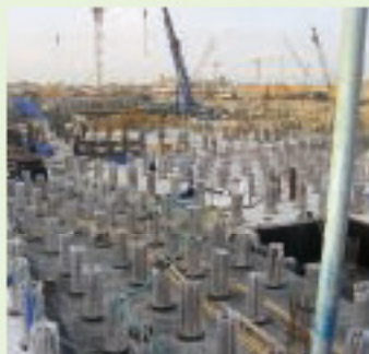
Апартаменты Палм Джумейра Марина, ОАЭ, гидроизоляция подвальной части
