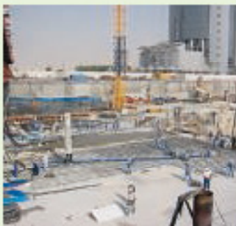
Башни-близнецы в Аль Фардане, Катар, гидроизоляция подвальной части
